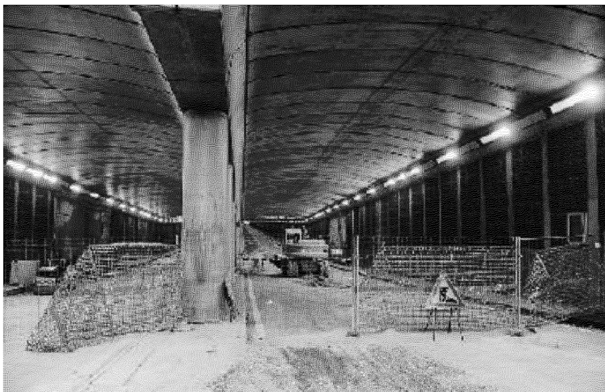
Una panoramica del sottopasso di corso Spezia prossimo alla riapertura
